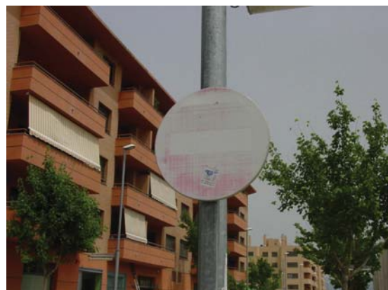
Senyal en estat deficient
