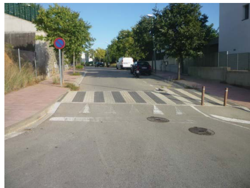
Imatge 40. Pas de vianants en plataforma al carrer de Pau Civil i Costa.
