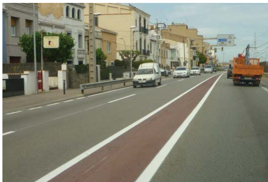
Imatge 109. Exemple en què s'ha establert una mitjana pintada, estrenyent els carrils de circulació. Tram urbà de la N-II.
