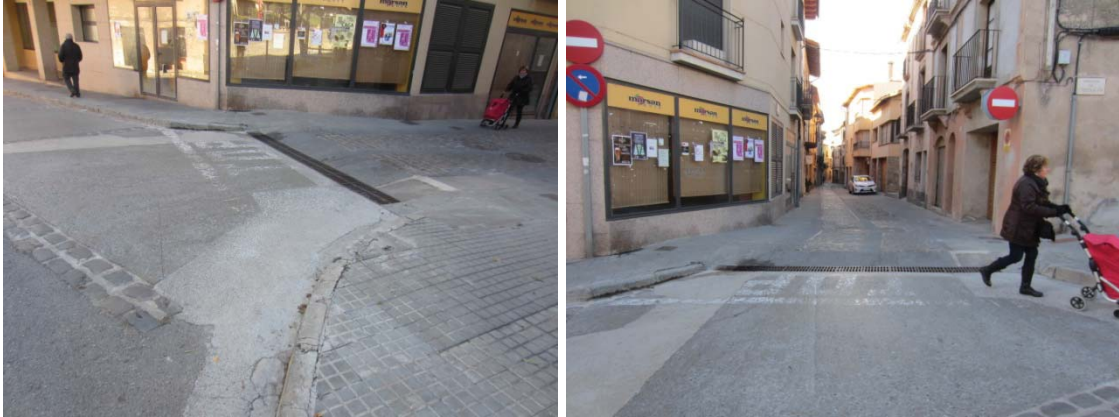
Imatge 105. Exemple de transició sense continuïtat entre voreres.
