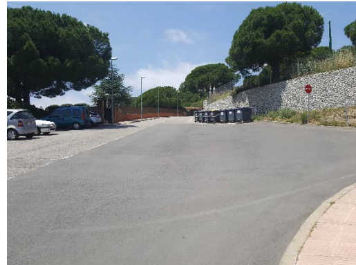
Imatge 82. Manca de marques viàries.
