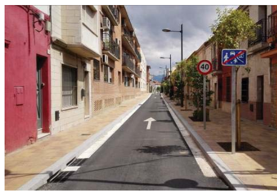
Imatge 110. Exemple d'estrenyiment de calçada en un àmbit plenament urbà, amb ampliació de voreres.
