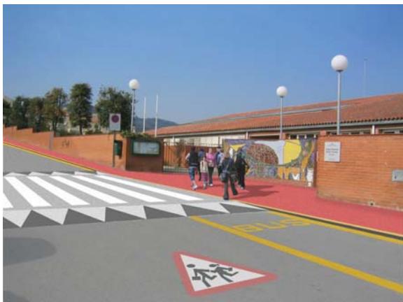
Accés immediat a l'escola mitjançant un pas de vianants elevat i amb reforç de la senyalització.
