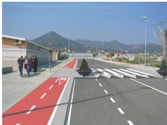
Construcció d'un carril de bicicletes i ampliació de la vorera creant un atri.
