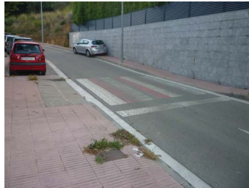
Imatge 18. Rampa i rebaix l'inici del carrer de Can Bassols.
