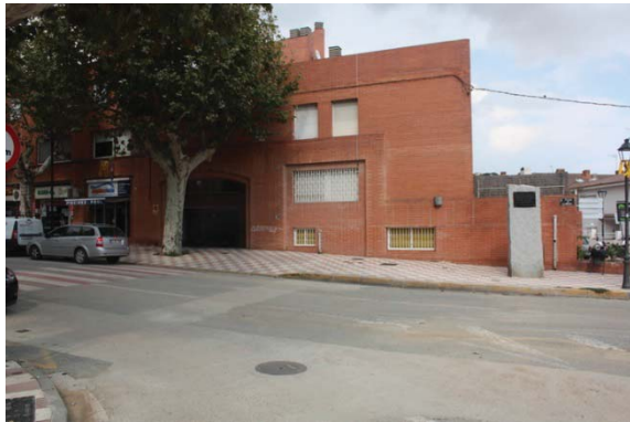
Imatge 50. Espai entre la porta de garatge privat i l'anella exterior de la rotonda.
