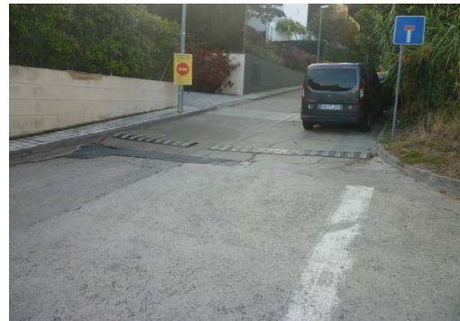
Imatge 35. Torrent de Can Mateu. Exemple de mala alineació en un estop.
