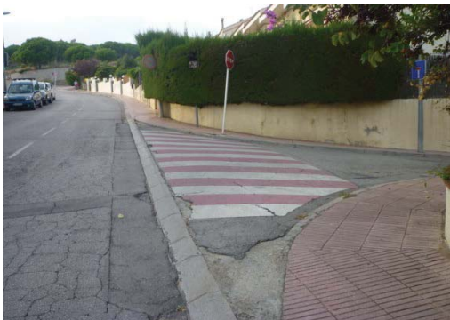
Imatge 24. Carrer del Cim. Exemple de pas de vianants ben traçat, com a continuació de les voreres que connecta.
